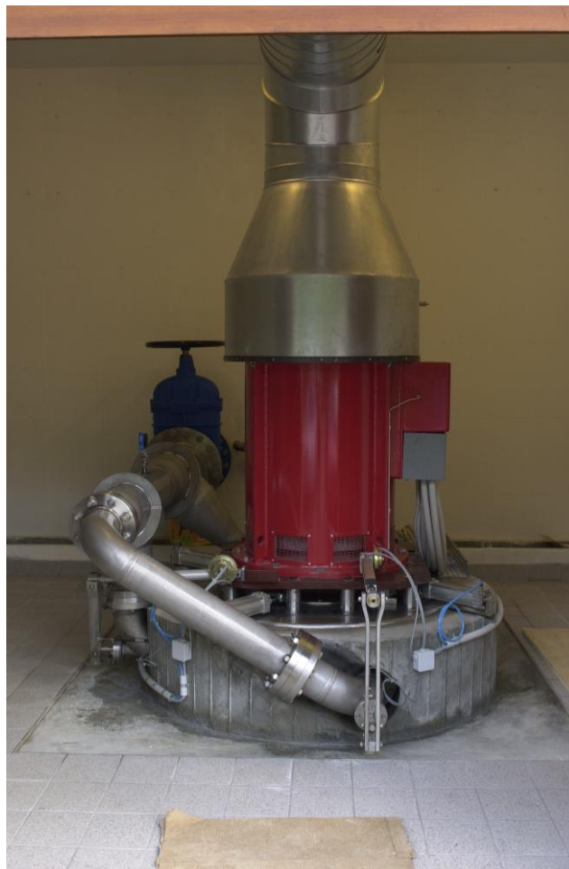
Groupe turbo-générateur de 282 kW
