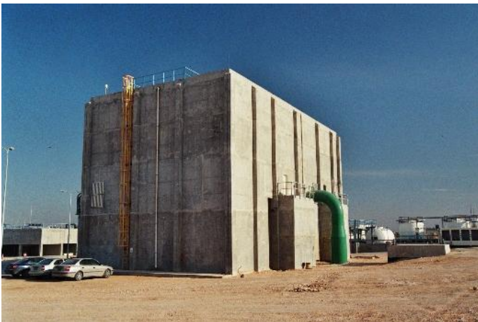
Fig. 1. Station de traitement d'As Samra : Structure d'entrée et usine électrique
