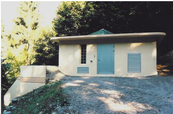
Petite centrale de la Rasse
