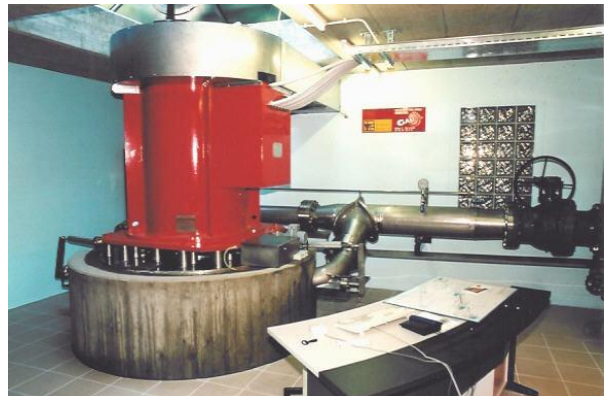
Groupe turbo-générateur 753 kW
