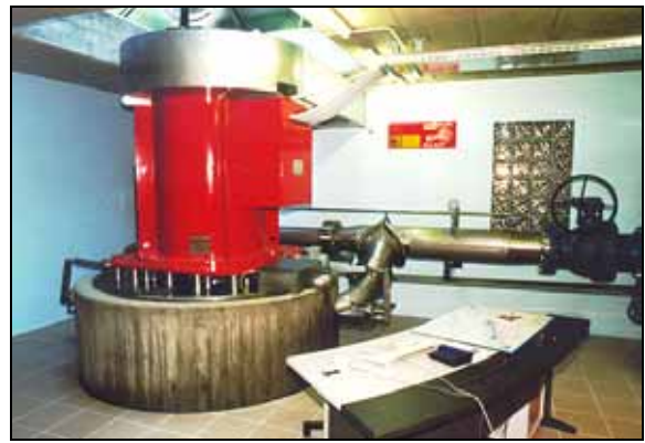
Groupe turbo-générateur 753 kW
