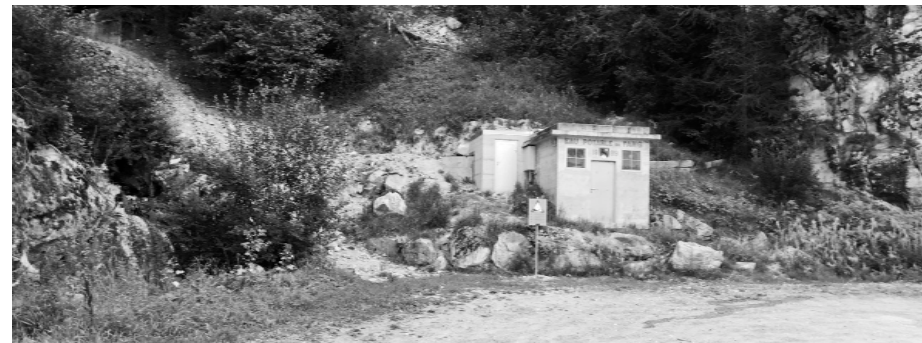
Figure 10. Le réservoir de Fang en septembre 2015, complètement enterré, avec à gauche le petit local qui donne accès au débitmètre et à la vanne de révision du dissipateur de Carnot (Source : Cerec Engineering)
