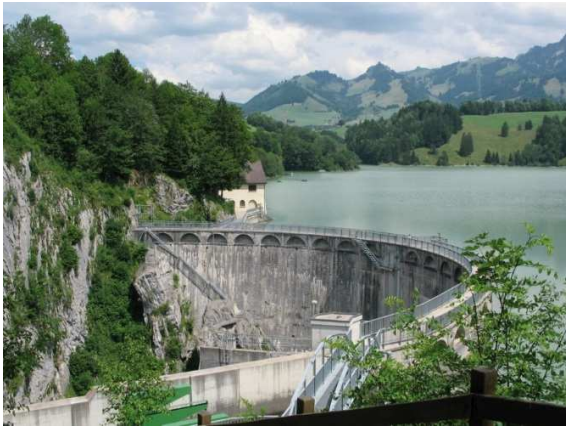
Figure 18 : Montsalvens dam (CH) (© Groupe e)
