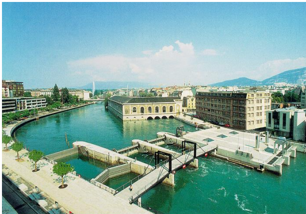
Figure 27. Aménagement du Seujet à Genève (© SIB)
