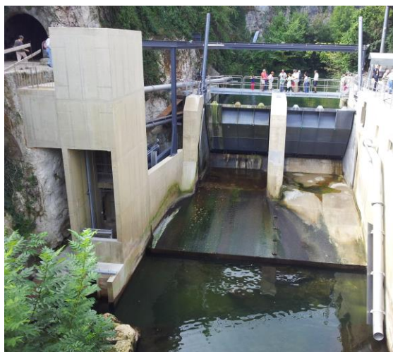
Figure 17. Ascenseur à poissons et passe à castors (pont en bois) de la centrale des Moulinets avant la mise en service (Orbe, Vaud, CH) (© Mhylab)
