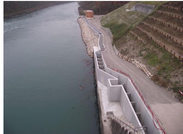
Figure 32. Echelle à poissons de Chancy-Pougny et local de turbinage du débit d'attrait ( Q_n = 4.6 \text{ m}^3/\text{s} , H_n = 12 \text{ m} , P_m = 410 \text{ kW} , grâce à une turbine Kaplan systématisée) (©SFMCP)
