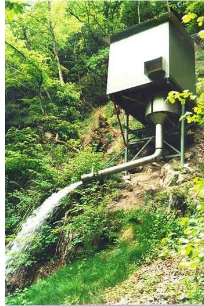
Figure 24. Turbine Pelton de la Douve II (Leysin CH) conçue sur la base de la systématisation, exploitant les eaux usées traitées de la commune de Leysin ( Q_n = 0.108 \text{ m}^3/\text{s} , H_n = 79 \text{ m} , P_e = 75 \text{ kW} , 380'000 \text{ kWh/an} , soit de l'électricité pour 85 ménages) (© Mhylab)
