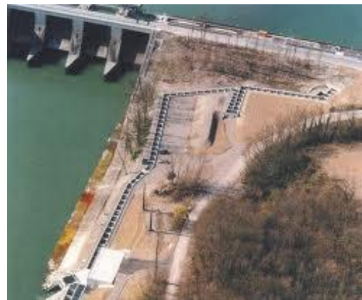
Figure 30. Echelle à poissons du barrage de Verbois et local de turbinage du débit d'attrait ( Q_n = 2.0 \text{ m}^3/\text{s} , H_n = 21 \text{ m} , P_m = 350 \text{ kW} ) (© SIG)
