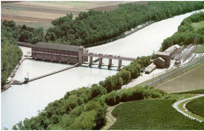
Figure 31. Aménagement de Chancy-Pougny (©SFMCP)
