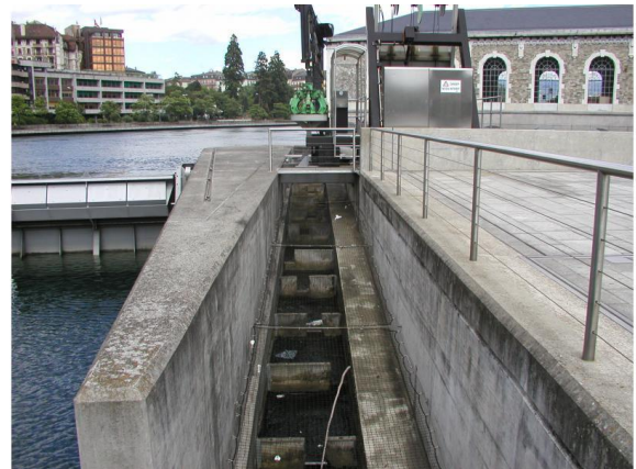
Figure 28. Echelle à poissons de la centrale du Seujet (© SIG)
