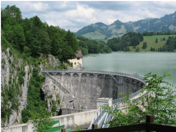
Figure 25. Barrage de Montsalvens (Fribourg, CH) dont le débit de dotation est turbiné (© Groupe e) [7]
