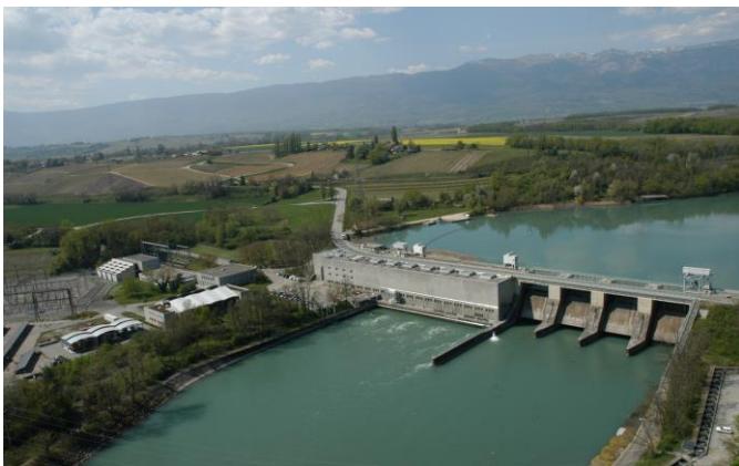
Figure 29. Aménagement de Verbois (© SIB)
