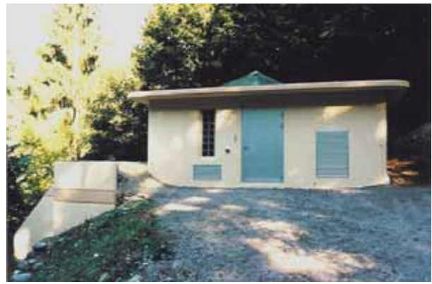
Fig. 8 Centrale de La Rasse
