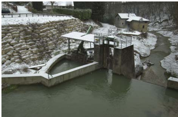
Figure 5. St-Bueil: prise d'eau
