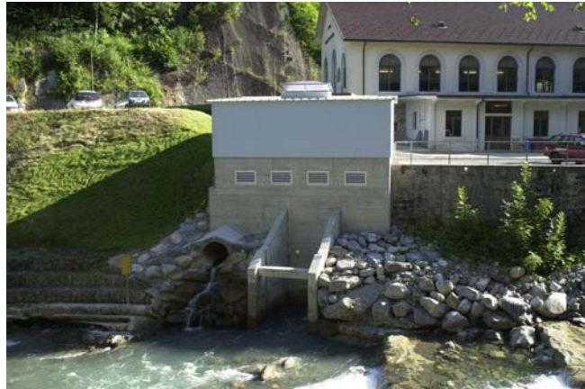
Figure 2. La petite centrale des Farettes (en arrière plan: la grande centrale haute chute)
