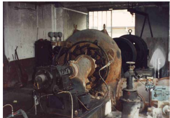
Figure 6. St-Bueil: ancien groupe Francis, encore en fonctionnement
