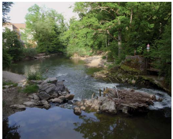
Le seuil aujourd'hui partiellement détruit de la Chocolatière, vu depuis l'amont, avec en rive droite la prise d'eau pour la petite centrale.
